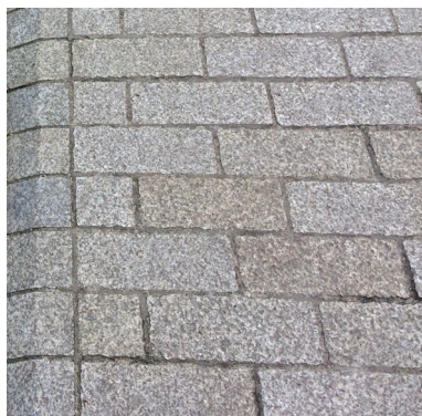
Ryc. 1: przykładowa forma nawierzchni pieszo-jezdnej z elementów kamiennych, granitowych
