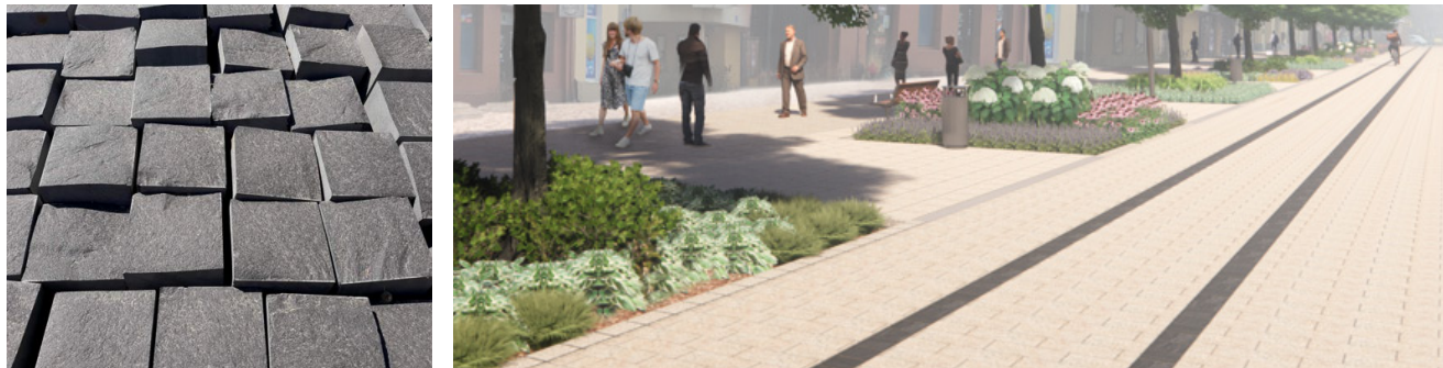
Ryc. 2: bazaltowa kostka brukowa wyznaczająca optycznie trasę dawnej kolei EKD
