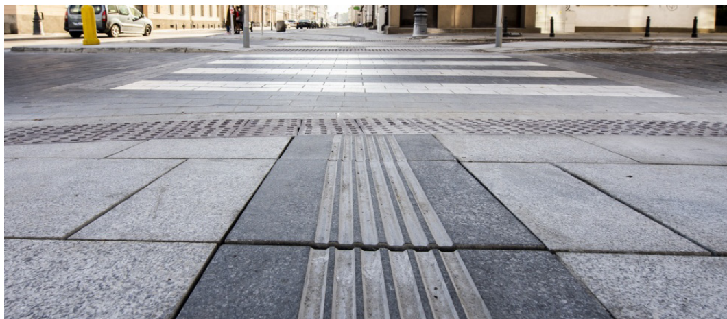
Ryc. 3: oznaczenia fakturowe w nawierzchni chodnika dedykowane dla osób niedowidzących i niewidomych
