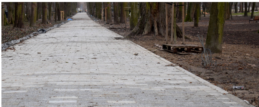
Ryc. 1: przykładowa forma nawierzchni pieszo-jezdnej z elementów kamiennych, granitowych
